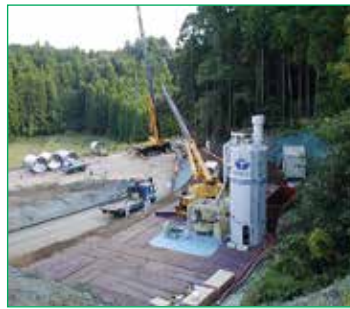
①管搬入立坑の設置
