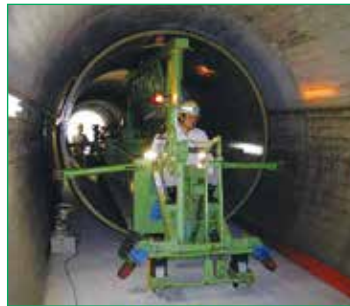
④既設水路内運搬
