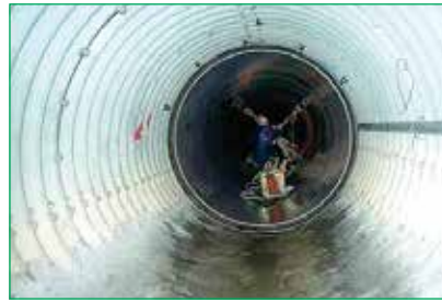
コルゲート管改修
