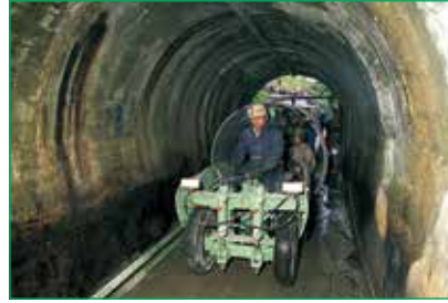
馬蹄形渠改修
