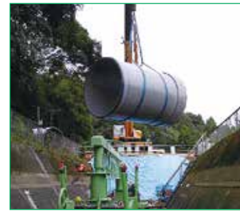
②管の吊降し
