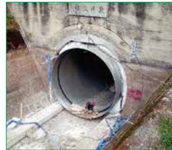
⑥裏込め材打設
