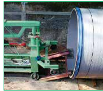
③運搬台車の引き込み
